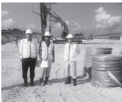
現場でPVDを確認する日本の建設関係者
