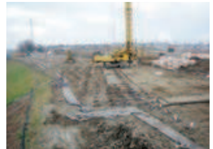
鉛直ドレーン打設 従来のプラスチックドレーンと同様の機械で打設します。
