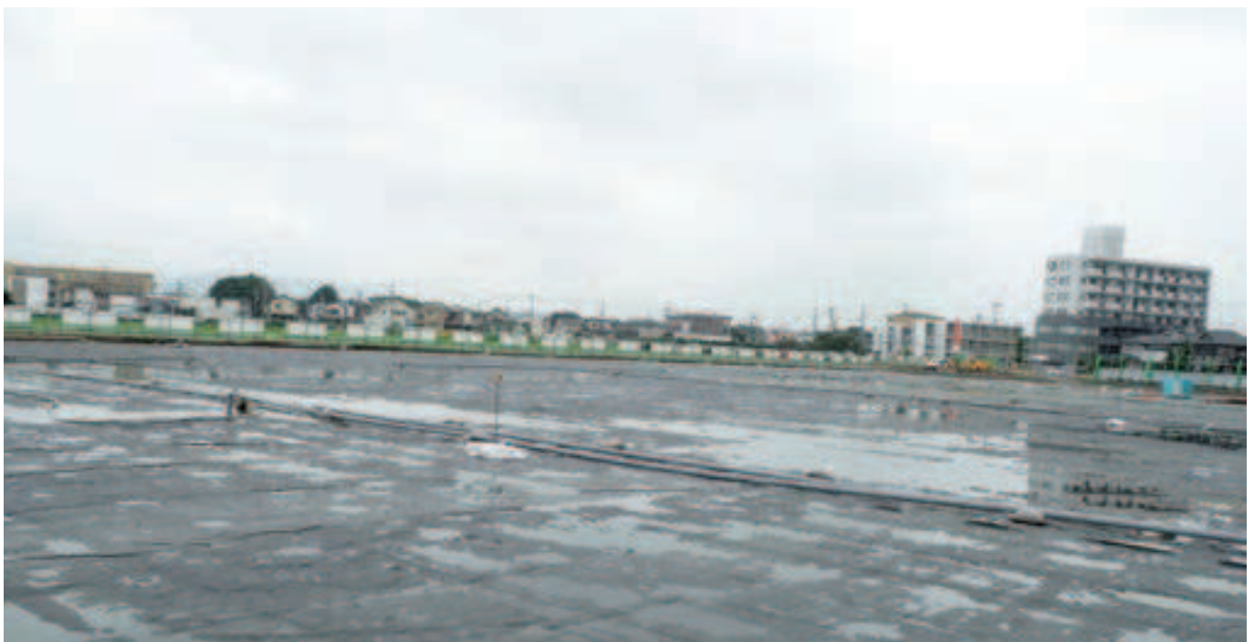
ポンプ運転状況(例)
