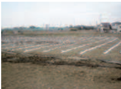
水平ドレーン・配管 排水システムである水平ドレーン、集水管を布設します。
