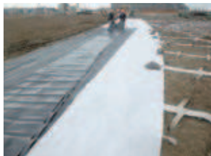
大気圧シート・保護シート敷設 大気圧シートの破損防止のため、地盤と大気圧シートの間に保護シートを敷設します。
