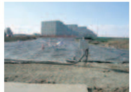
ポンプ運転状況 計測管理を行いながら、所定の目標値に達するまで運転します。
