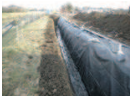
シート端部処理 シート端部は改良エリアの外側に埋込み漏気を防止します。
